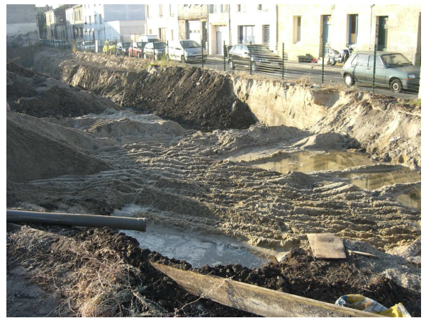
Excavation en cours dans la zone de substitution
