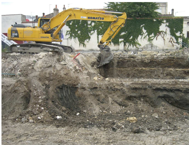
Décapage des sols par passe de 50 cm
